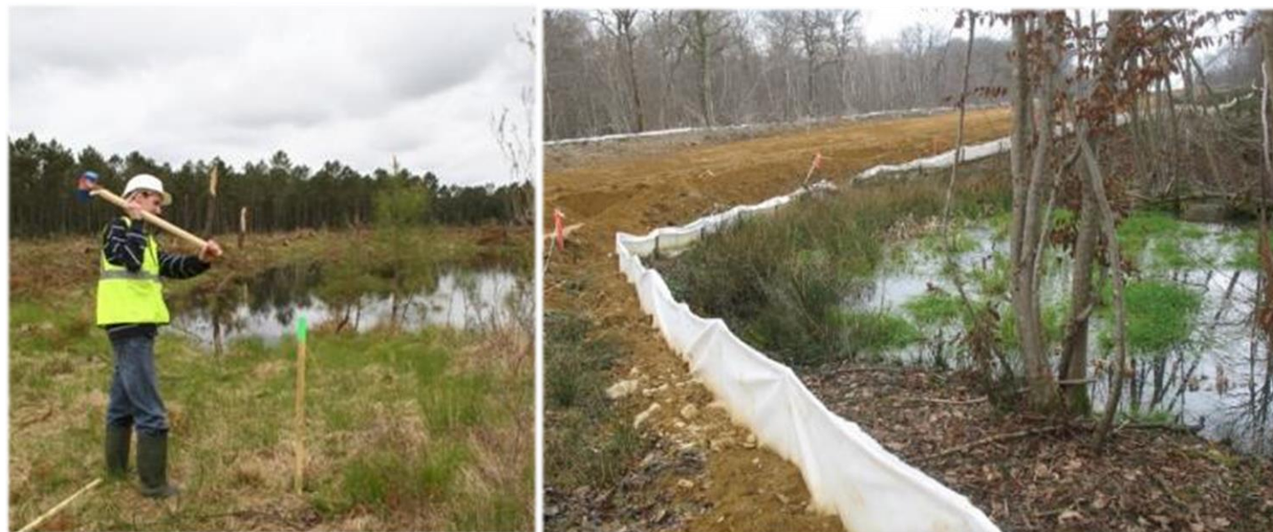
Exemples de balisage et limitation de l'emprise du chantier sur les zones humides (à gauche, Source : Abies, A. Petit – RFF) et Grille de choix du type de clôtures en fonction de l'objectif recherché (à droite : source : SETRA « Clôtures routières et faune » / J. CARSIGNOL – CETE de l'Est
